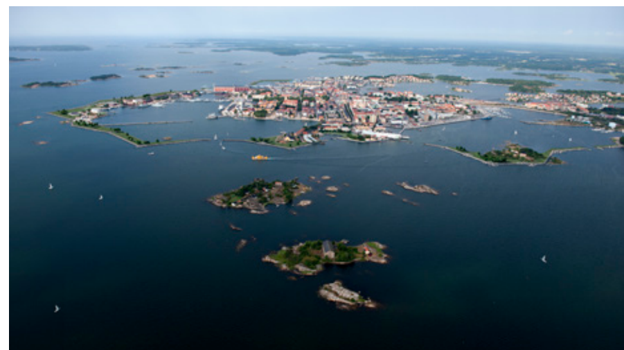
Kustskyddet runt centrala Karlskrona runt år 2100.
