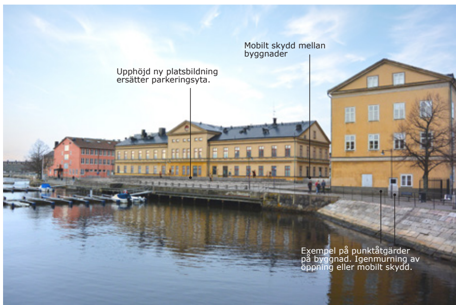
Exempel på enkla åtgärder som skyddar upp till +2,5 meter men inte förvanskar byggnader och stadsmiljö.
