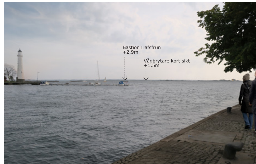
Vågbrytare med höjd cirka 1,5 meter.
