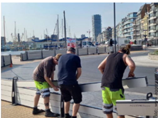
Mobila och tillfälliga skydd. Exempel på skydd för byggnad och skydd för stadsmiljö. Exempel från Nederländerna.
