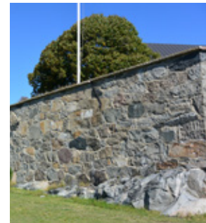
Exempel på material för uppbyggnad av kustskydd. Jord/gräs, stenvmurar och trä. Exempel från Landskrona, Stumholmen och Helsingborg.
