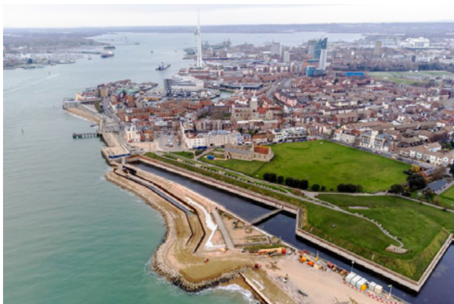
Konstruerade skydd mot översvämning. Portsmouth, England.
